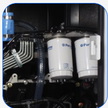
Filtro separador de partículas de combustible
